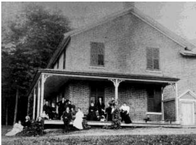
Maison de Frederick James Beckett construite dans les années 1870, au bout de l'Allée des saules
